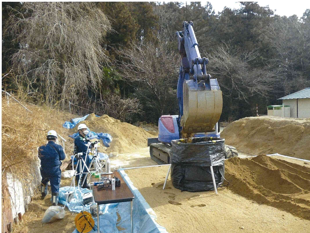
写真5 山砂を用いた模擬的な除染作業風景
