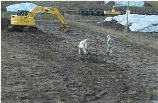
図9 除染作業現場の様子
