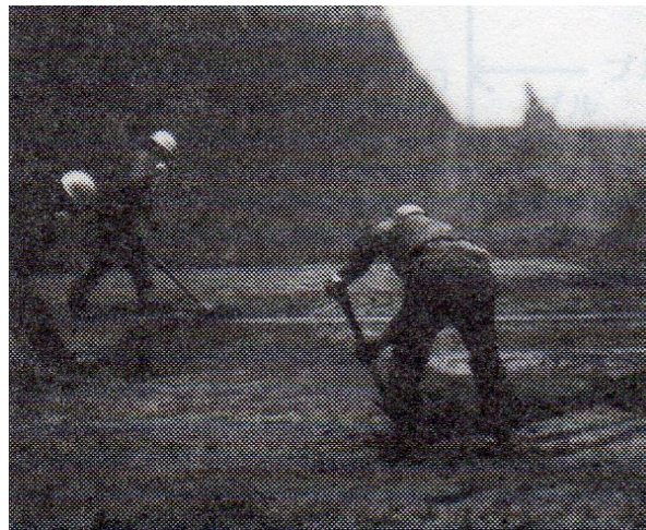
図 4.1 船倉内で船底の銅精鉱をスコップにてかき寄せる作業の状況
