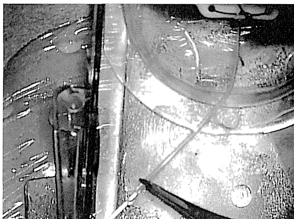
図6 チューブ通水確認① チューブの先端にBSSを通す。
