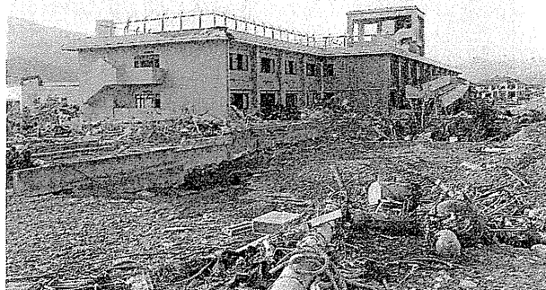
図2 被災した老人保健施設。津波が2階部分をも埋め、多くの入居者が犠牲になった。
