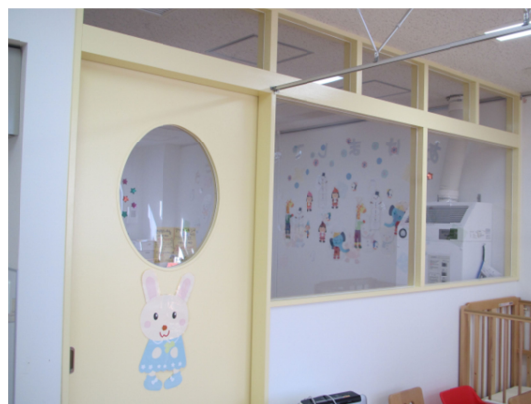
図 11-b. 陰圧換気の隔離室 隔離室との間も、クリアパネルや強化ガラスにすることにより、お互いの状況がわかります。
