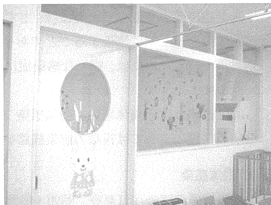
図 11-b. 陰圧換気の隔離室 隔離室との間も、クリアパネルや強化ガラスにすることにより、お互いの状況がわかります。
