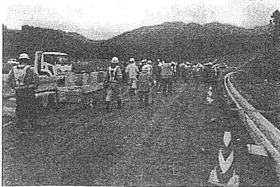
写真1 造成工事現場見学会の様子(2014年9月5日)
