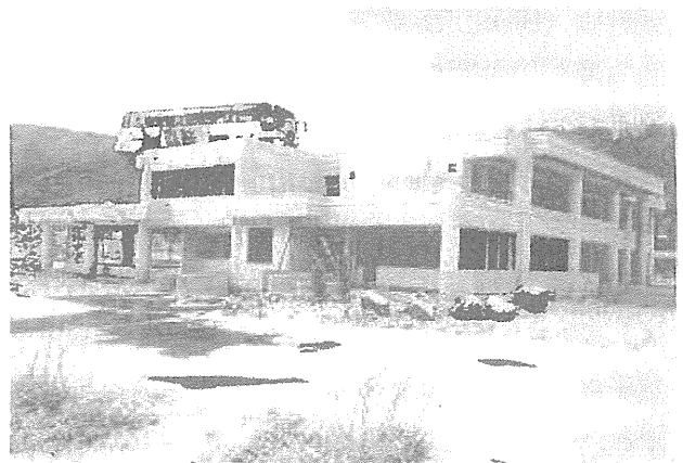
写真 1：被災した石巻市雄勝公民館
