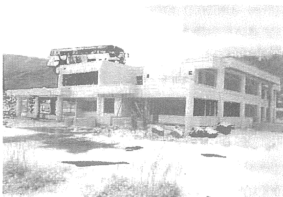
写真 1：被災した石巻市雄勝公民館
