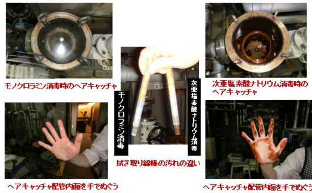
図7 モノクロロアミン消毒時と次亜塩素酸ナトリウム消毒時のヘアキャッチャー配管内面の拭き取りによる比較
