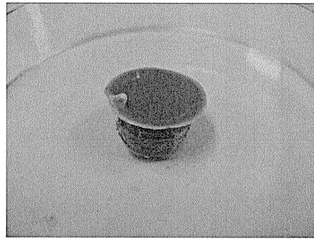
図2 くり抜いた配管(配管 No.1)
