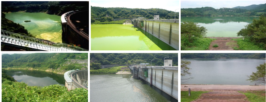
写真1 曝気循環設備増設前（上）と、増設後（下）のダム貯水池の状況（左からB、C、Fダム）
