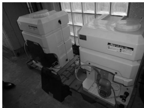
図 25 二段凝集処理設備の設置事例
