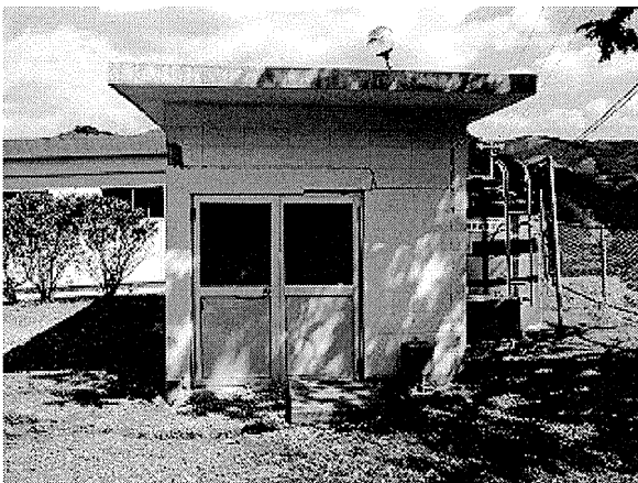
次亜注入ポンプ室の状況
