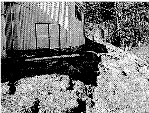
ろ過池周辺の盛土の状況
