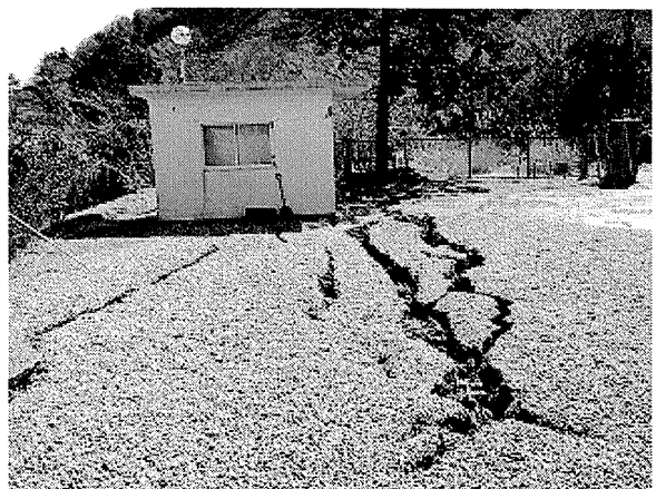
次亜注入ポンプ室周辺の盛土の状況
