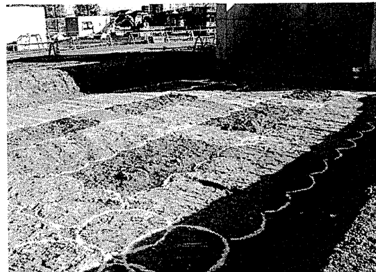
図 R8.11 機械攪拌工法 施工状況 参考文献(2)から引用
