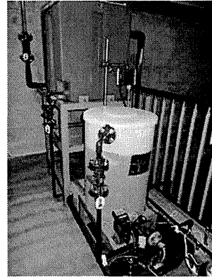
写真 7-3 二段凝集の PAC 注入設備の実例
