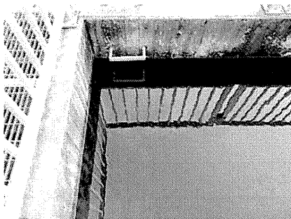
写真 7-1 タラップと整流孔
