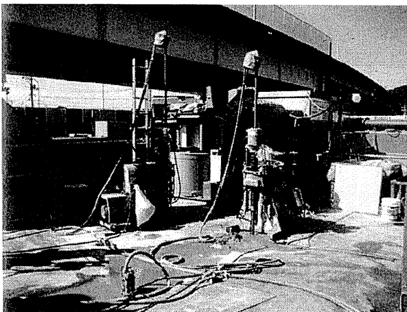
図 R8.18 薬液注入 施工状況 参考文献(2) から引用
