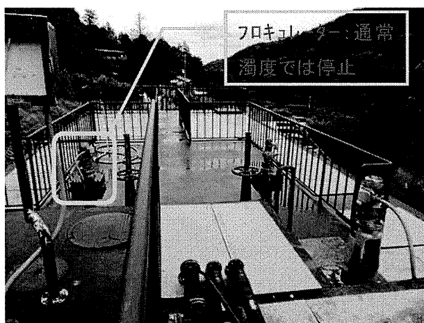
(7) 新系：着水井～凝集沈澱池
