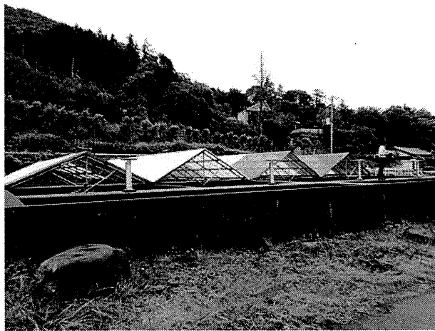
(4) 旧系：沈澱池（傾斜装置なし）
