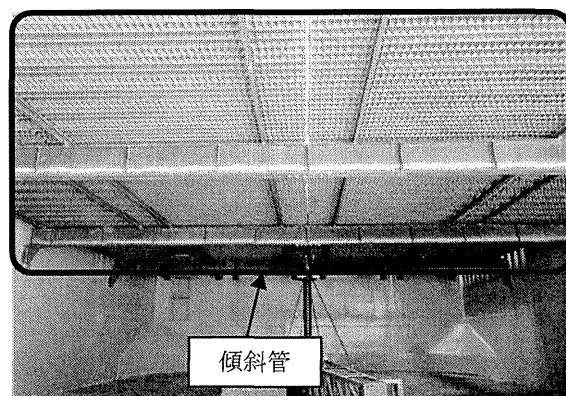
沈澱池 (内部から)
