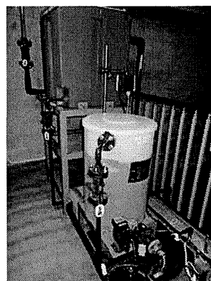
写真 7-3 二段凝集の PAC 注入設備の実例
