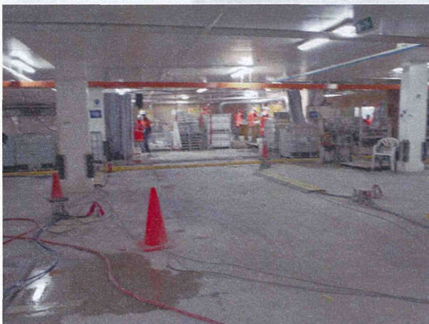
写真-4.11 クライストチャーチアートギャラリー地下の沈下修正工事現場
