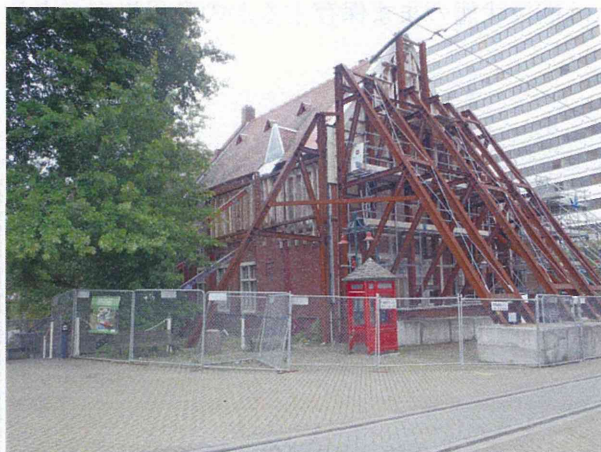
鉄骨による補強がされている
