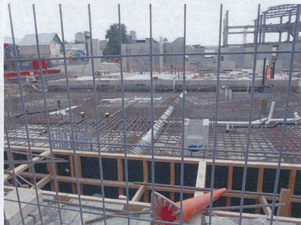
新築工事中の建物
