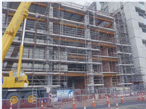
市役所隣で建設中の建物
