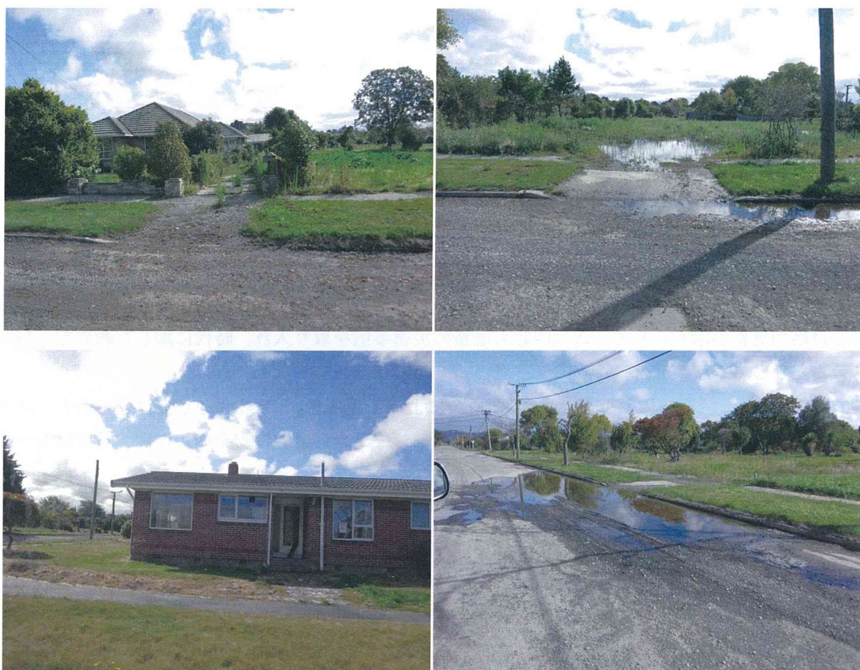
写真-4.9 Burwood 地区の被災状況
