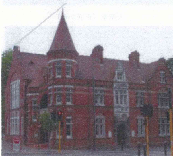
被災前の旧市議会議場
