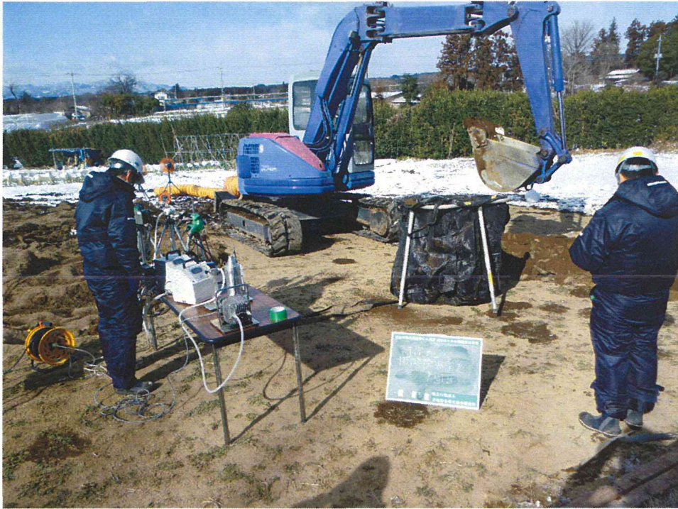
写真7 水田における模擬的な除染作業風景
