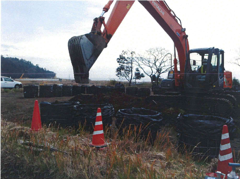
写真1 重機によって汚染土壌がフレコンバックに回収される
