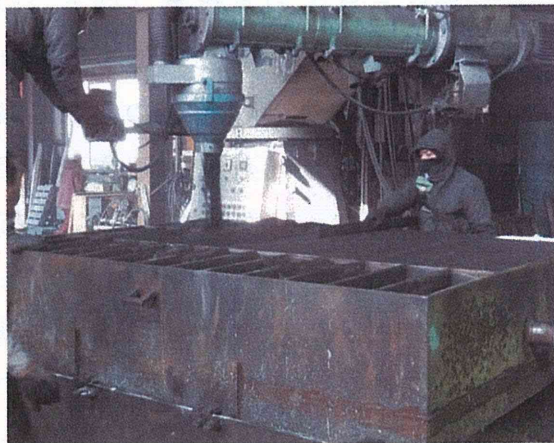
図 2.2 手込め作業風景
