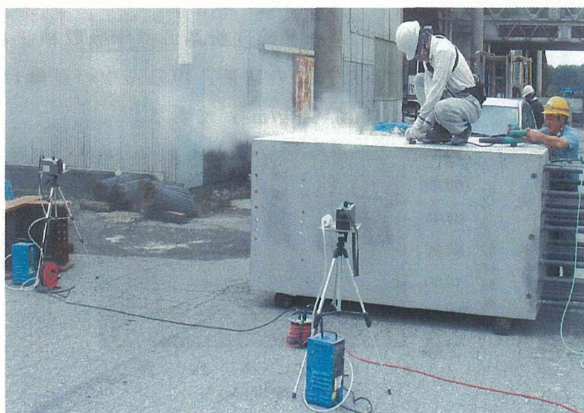
図 1.3 コンクリートに対する研磨・ばり取り作業の測定
