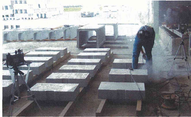
図.4 コンクリートに対する研磨・ばり取り作業の測定
