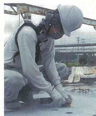
図 1.2 コンクリートに対する研磨・ばり取り作業の様子
