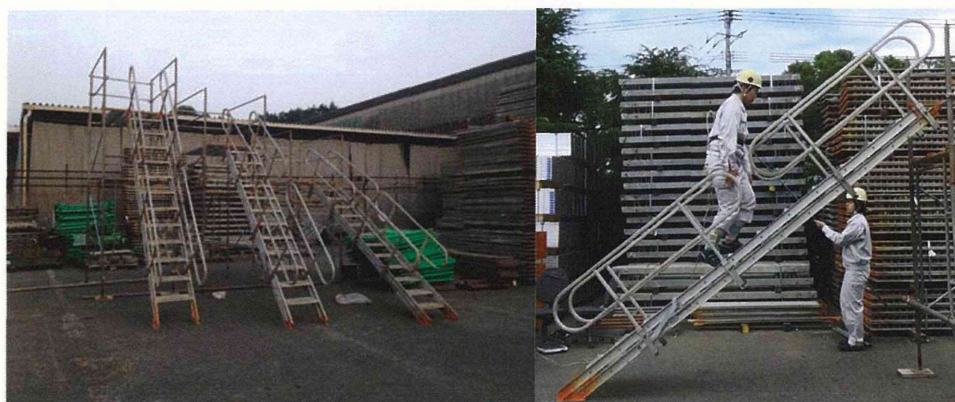
図 C-3-2-5-1 仮設階段の概観と歩行実験の様子
