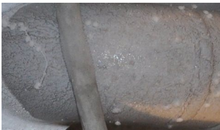
メイン放出配管表面の拡大写真
