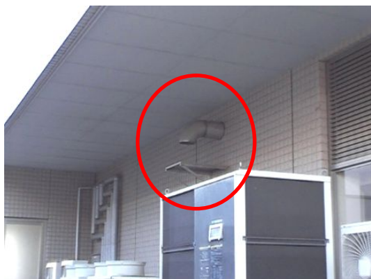
クエンチ前の屋外放出口 00:15
