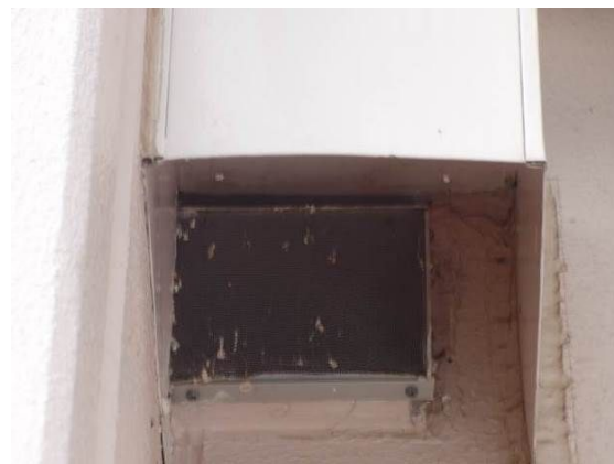
屋外放出口を下から覗いた内部の様子
