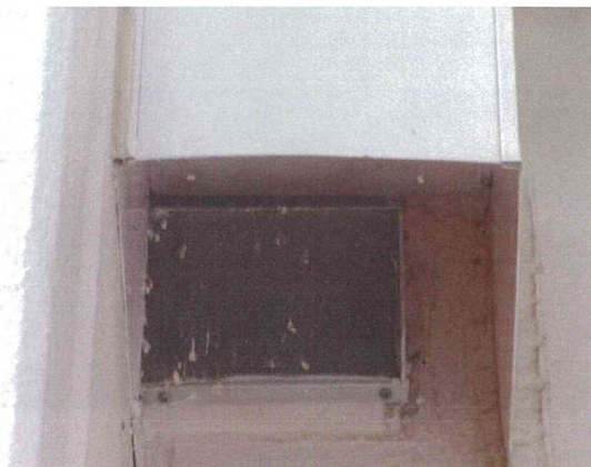
屋外放出口を下から覗いた内部の様子
