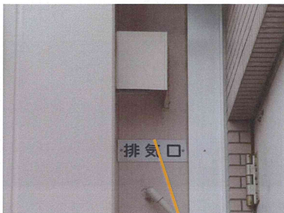
屋外放出口の設置場所
