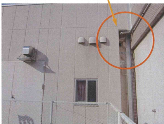
屋外放出口部分は建屋の隙間にある。
