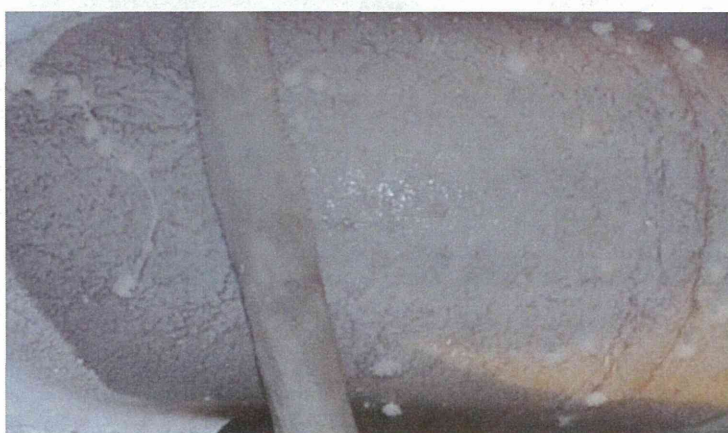
メイン放出配管表面の拡大写真
