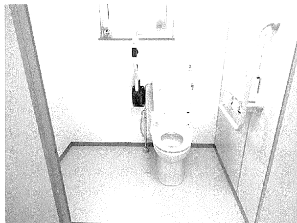
図 35 事例 0 の GH 等のトイレ
