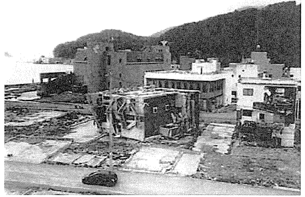
図8. 3階建てのコンクリートの建物の崩壊 (女川町)
