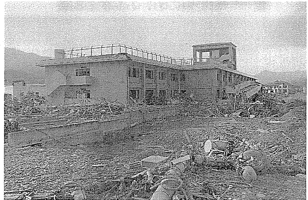
図2 被災した老人保健施設。津波が2階部分をも埋め、多くの入居者が犠牲になった。
