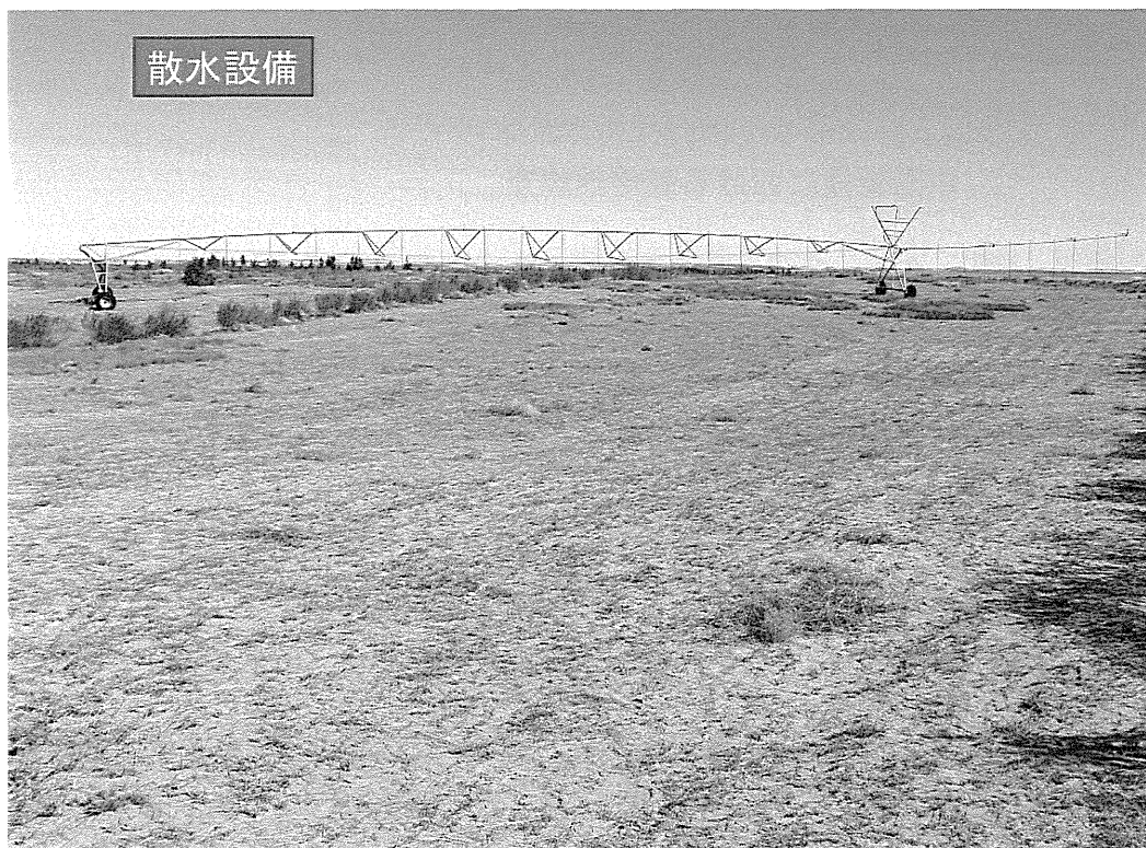
移動式の撒水設備
