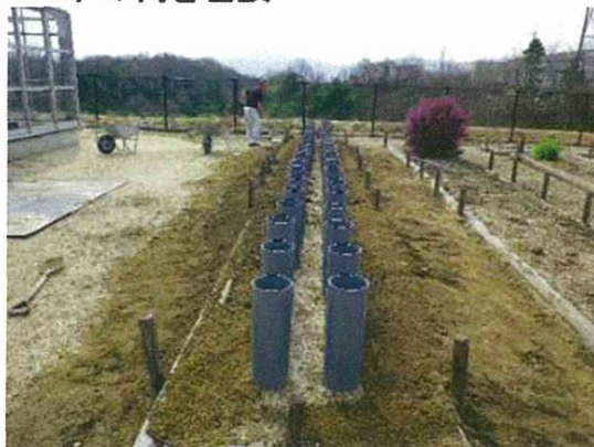
44本の筒を埋設
