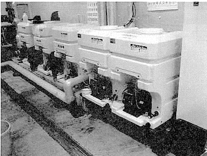
写真 3 . 静岡市施設のモノクロラミン生成装置
