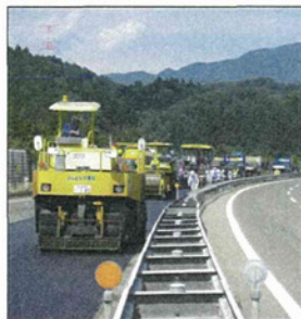
【山形道】仙台管内 舗装復旧状況
