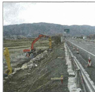
【東北道】福島管内 のり面復旧状況
