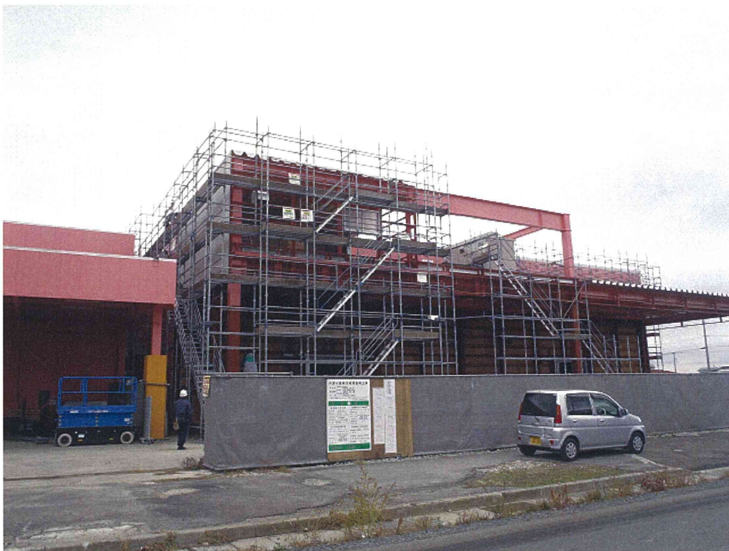
建設中の水産用冷凍庫
