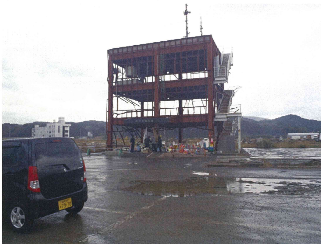
南三陸町防災対策庁舎
