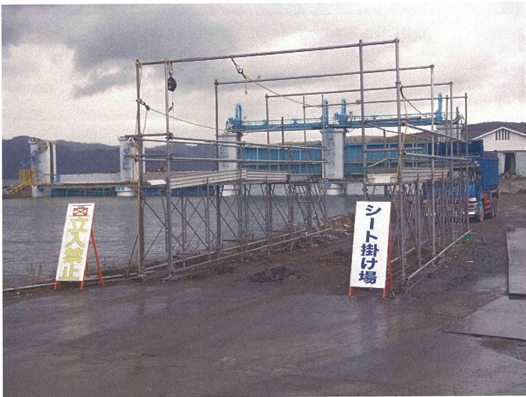
瓦礫処理場（松原公園）入り口にあるトラックのシート掛け場
