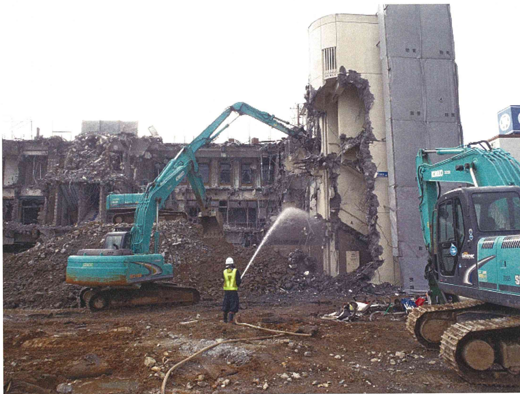
解体作業中の気仙沼市観光物産センター
