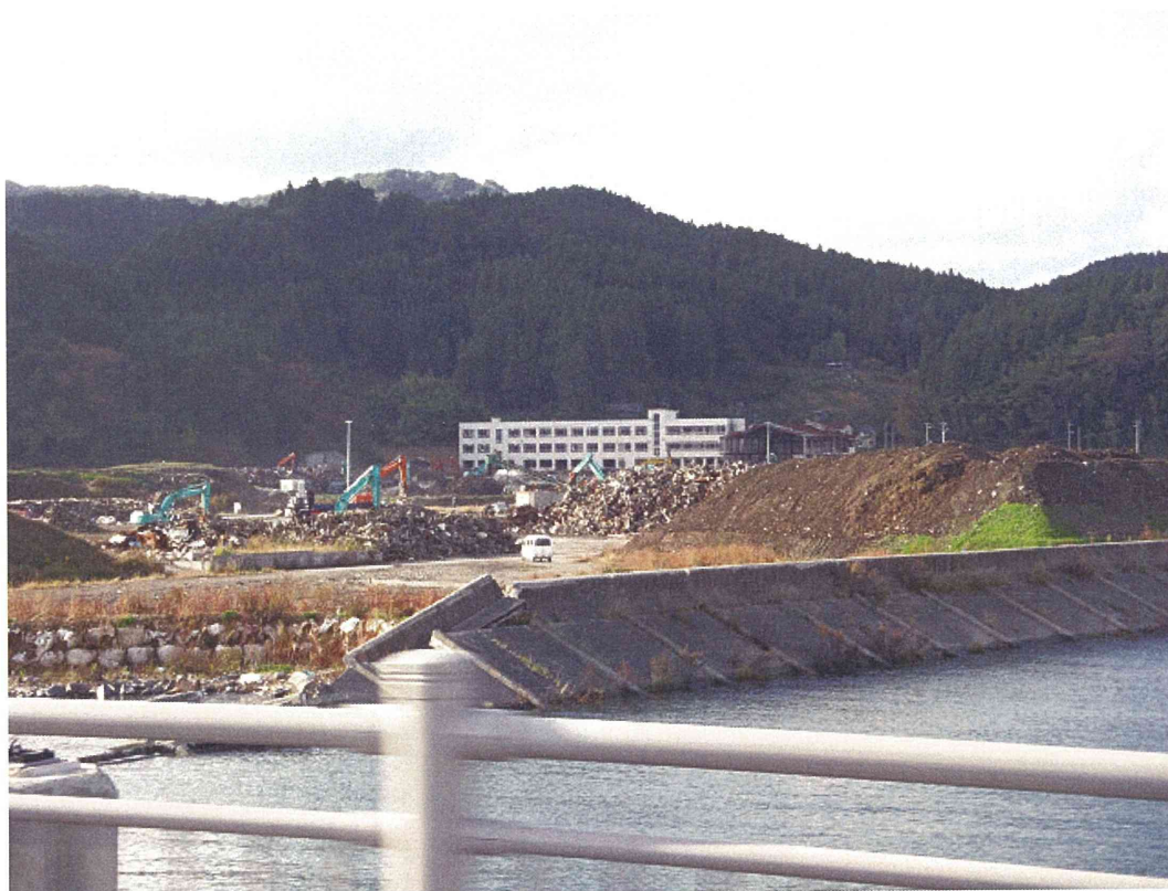
瓦礫処理作業の状況
