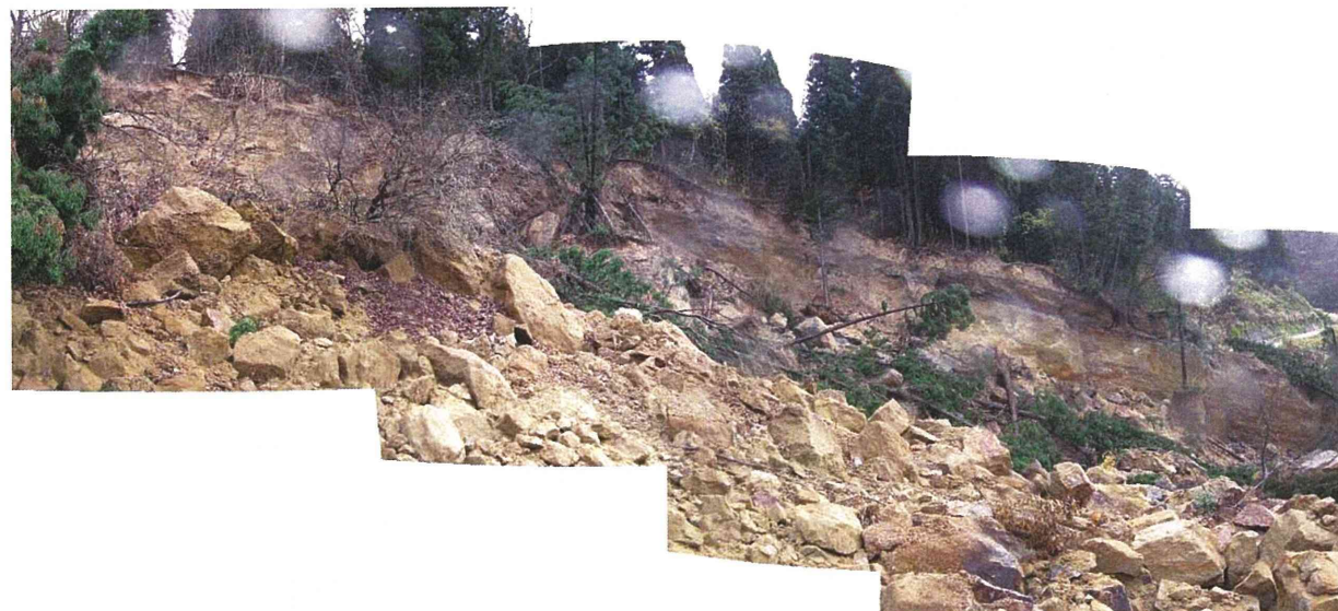
小千谷市真皿地区での大規模な斜面崩壊 (2004年11月15日 豊澤康男撮影)
