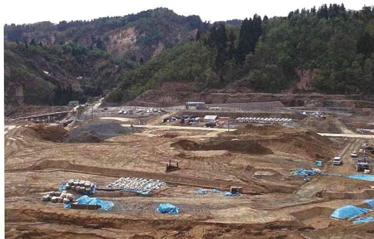
寺野地区災害復旧工事の様子 (河道閉塞後の対策工事) (2006年5月12日 伊藤和也撮影)
