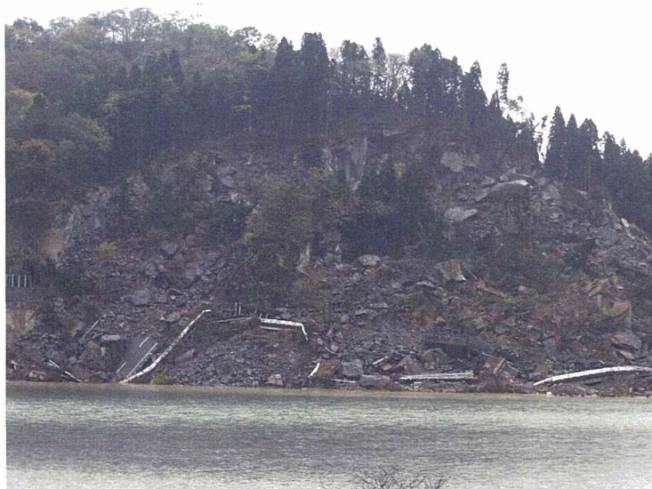
長岡市妙見町の県道が斜面崩壊によって通行不能となった。
