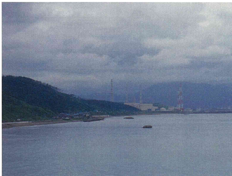
柏崎刈羽原子力発電所の遠撮 柏崎刈羽原子力発電所 3号機の変圧器にて火災が発生。地元消防の手で火災は消し止められた。 （2007年7月23日 伊藤和也撮影）
