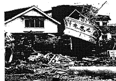
津波直後の津波で消防車と船が民家へ乗り上げた (青苗地区)
