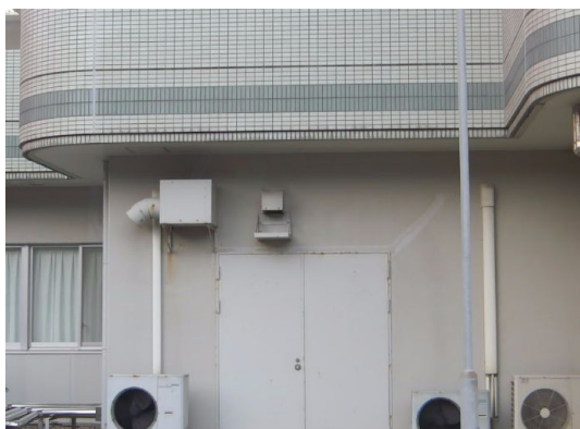
屋外放出口の配置付近
