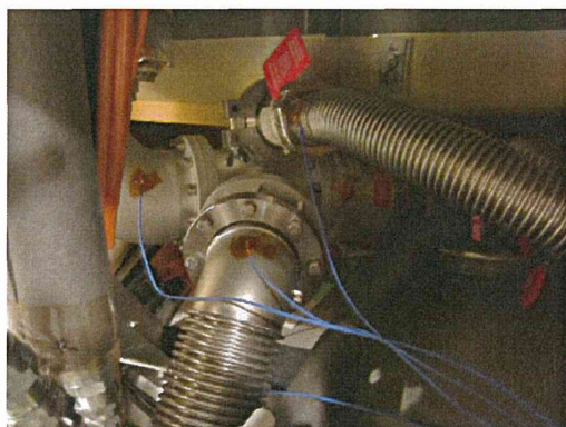
クライオ上部配管温度計取り付け位置
