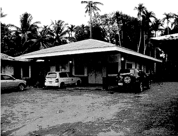
バベルダオブ島北部の保健センター 北部村落地域の一次医療を担っている。
