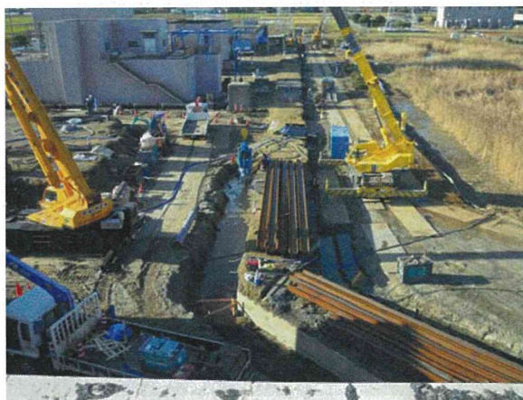
復旧状況（鋼矢板設置）
