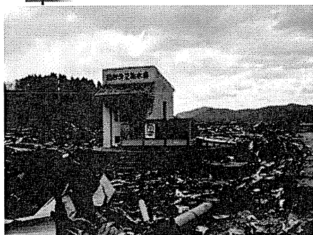
宮城県南三陸町助作第2取水場
