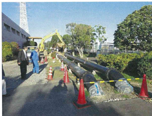
復旧状況（仮設管設置①）
