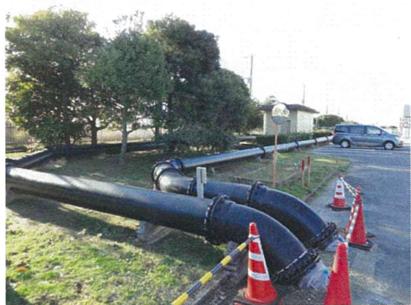
復旧状況（仮設管設置②）
