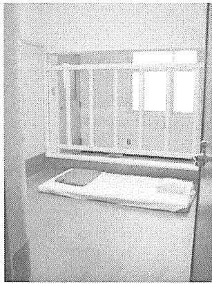
【図 22 肥前精神医療センター・換気口があり、観察廊下の窓は全開する】
