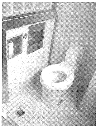
【図7 土佐病院・トイレスペース】
