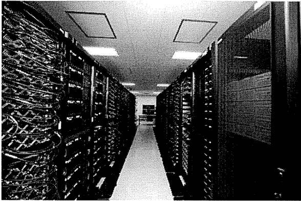
図 4. 分子動力学シミュレーション専用計算機 MDGRAPE-3 の写真。専用 LSI 約 4,800 個からなり、理論ピーク性能 1PFLOPS の性能を持つ。
