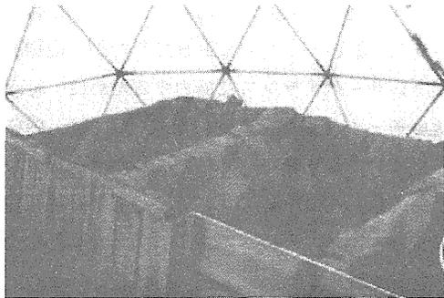
図 12 ブルーシートを利用した仮設浴槽
