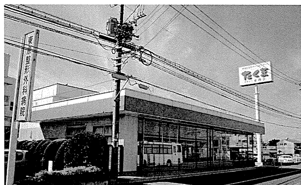
写真8-3. 自動車販売店の改修事例（コムネ）
