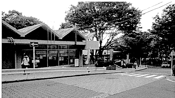
写真5-1. 地域交流拠点と道路の結節点（公田団地） T字路の突き当りに地域交流拠点が立地
