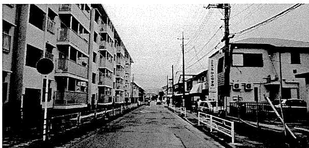
写真5-2. 団地との接点に立地（ふれあい処） 団地と向かい合う地域交流拠点
