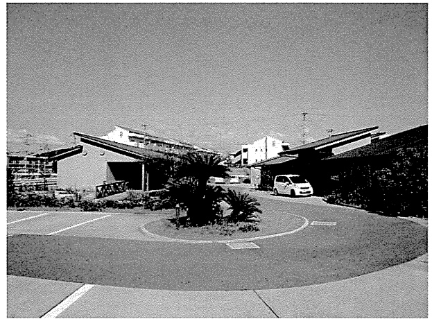
写真4-1. 敷地内の通り抜け道路（なごみ） 敷地内をアスファルトの道路が通る。写真左側が地域交流拠点
