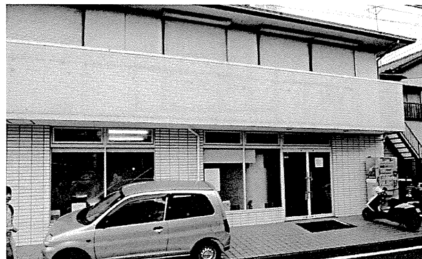
写真8-4. コンビニエンスストアの改修事例（わくわく）
