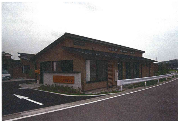
写真7-1. 敷地全面に立つ地域交流拠点（なごみ） ガラスの面が広く開放的 全面窓ではあるが木の格子により適度に視線を遮る 開放的ながらも落ち着く空間
