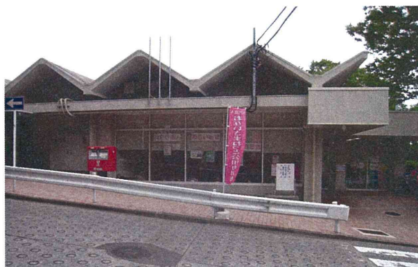
写真7-2. ガラス張りの概観（公田団地） 歩道との段差があり、内部からは歩行者の視線が気にならない
