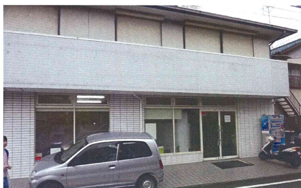
写真8-4. コンビニエンスストアの改修事例（わくわく）
