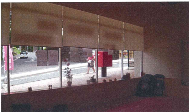
写真13-2. 見守りやすい窓（公田団地） 段差があり通行者と視線が交差しない
