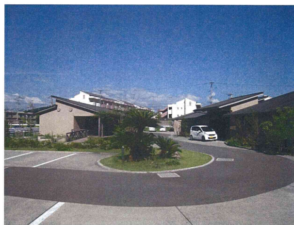
写真4-1. 敷地内の通り抜け道路（なごみ） 敷地内をアスファルトの道路が通る。写真左側が地域交流拠点
