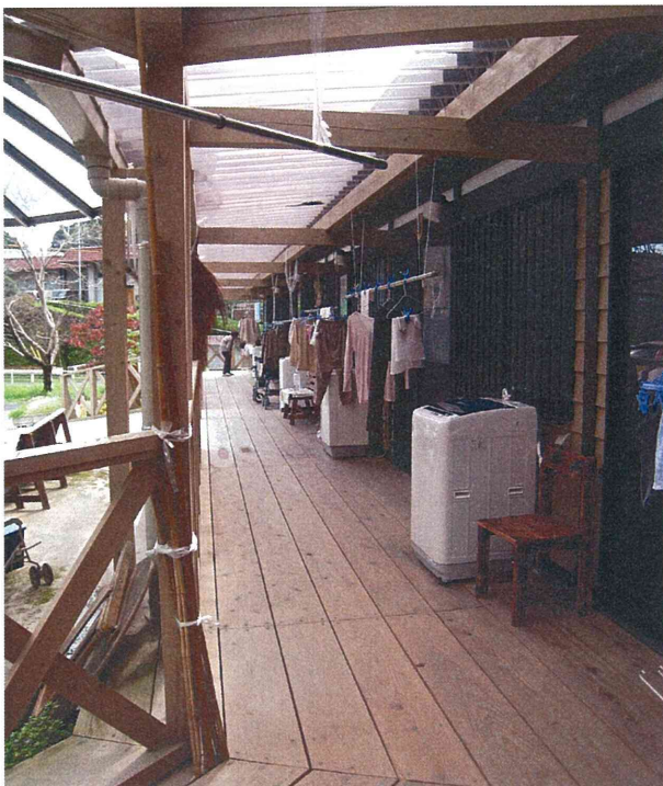
写真1-2. リビングアクセス形式の居室前廊下（ろんち） 居室前にはベンチが置かれ積極的な他者との交流が誘発される
